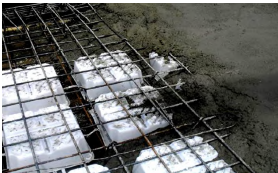
شکل (۷-۱۰): بتن‌ریزی تکمیلی در سقف یوبوت
