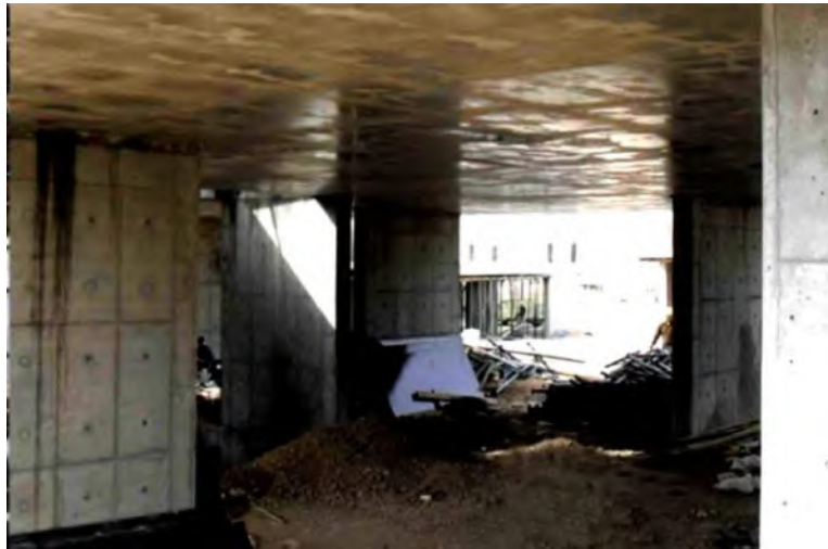
شکل (۷-۱۱): باز کردن قالب‌های کف
