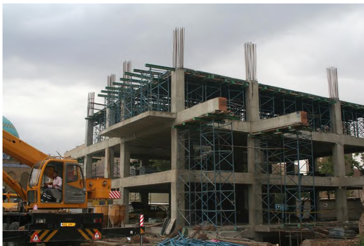
شکل (۷-۲۲): ساختمان نمایندگان مجلس در حال احداث
