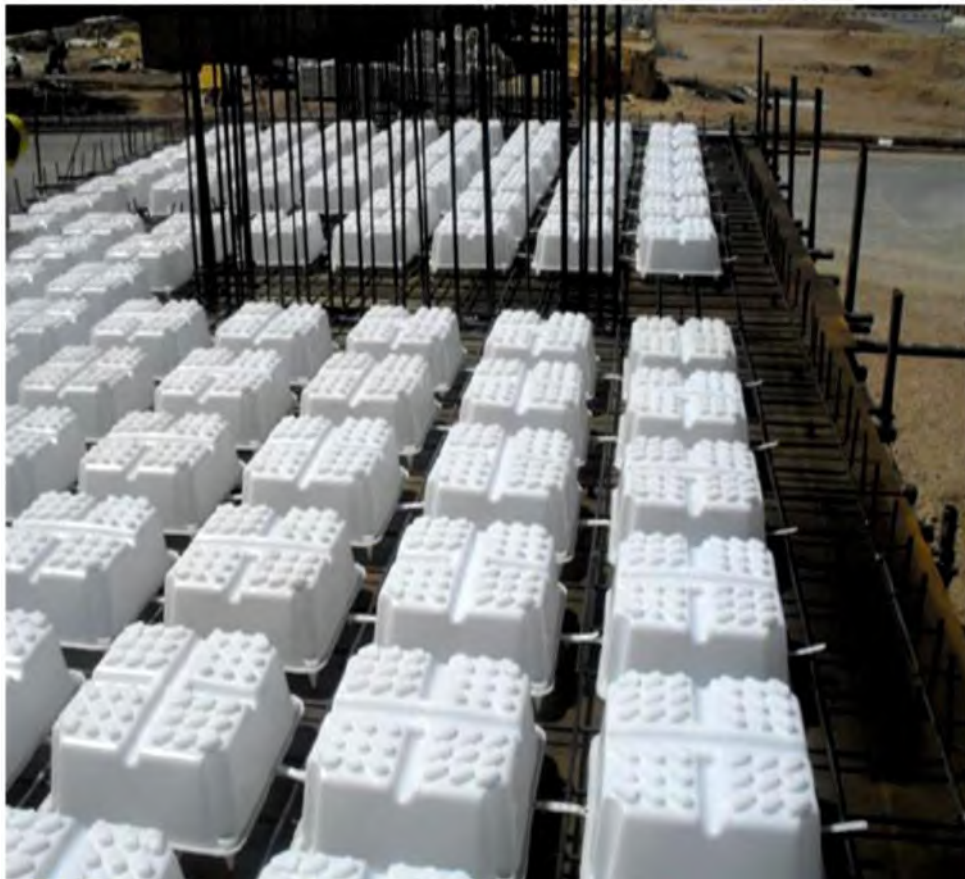
شکل (۶-۷): آرماتورگذاری سفره تحتانی در سقف یوبوت
