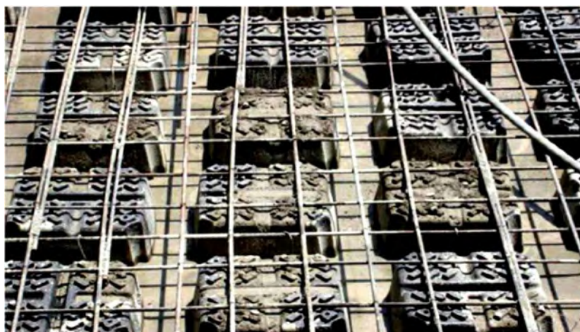
شکل (۷-۹): بتن‌ریزی لایه اول در سقف یوبوت
