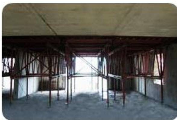
شکل (۳-۶) : قالب میز پرنده
