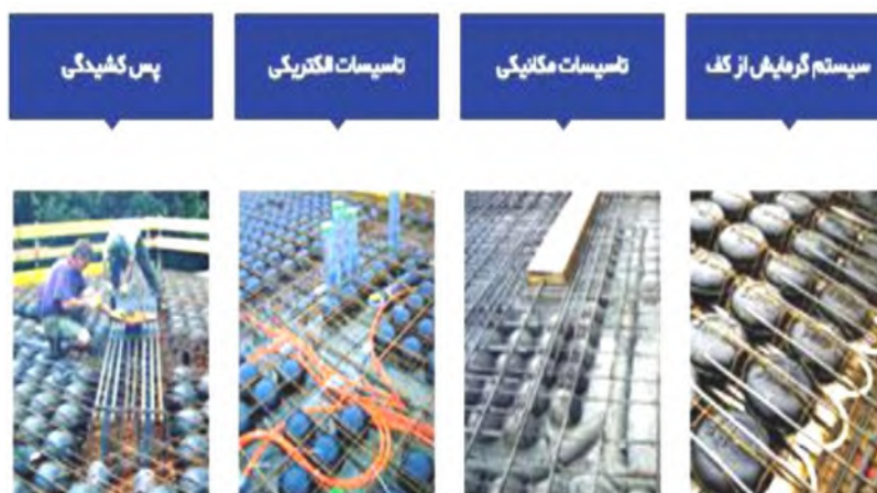
شکل (۸-۲): نحوه‌ی اجرای تأسیسات مکانیکی و برقی
