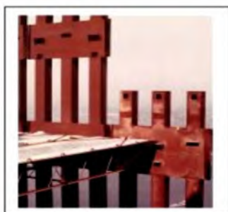
شکل (۷-۱۲): استفاده از تیرهای فلزی با جان باز در ساختمان‌های دوقلوی مرکز تجاری جهانی در نیویورک
