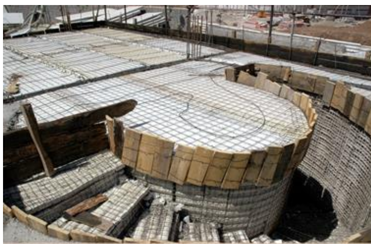
شکل (۶-۱۱): پانل سقفی
