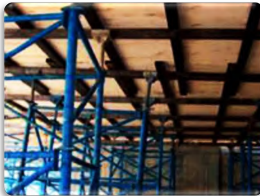
شکل (۷-۵): قالب‌بندی سطح زیرین دال
