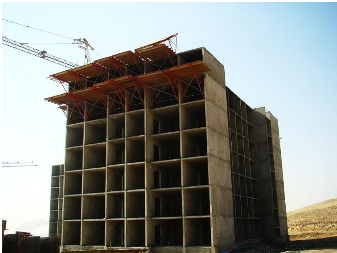
شکل (۲-۳) : عملکرد جعبه‌ای سیستم قاب بتنی پیوسته (قالب تونلی)
