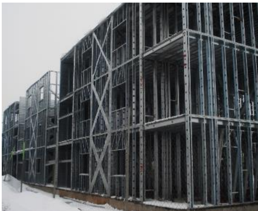
شکل (۴-۲۸): دهانه مهاربندی شده با مهاربند ضربدری
