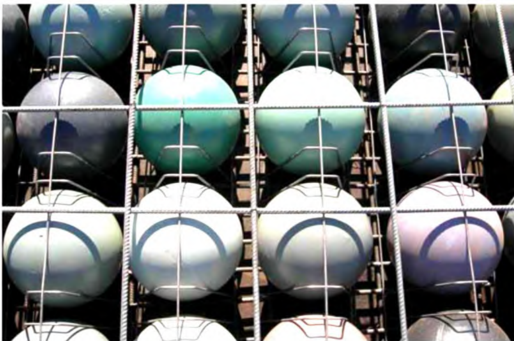
ث- بتن ریزی و ویبره
