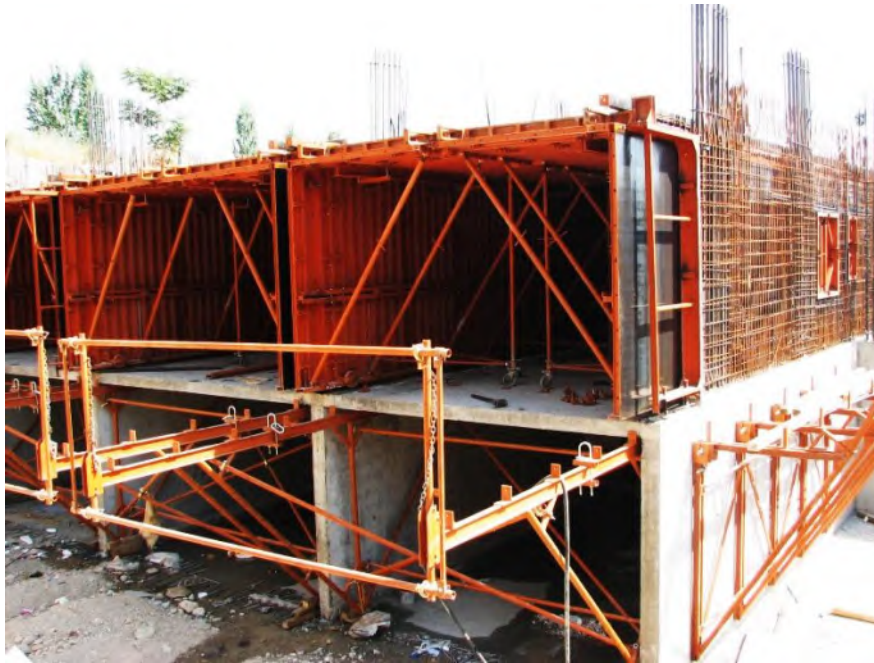
شکل (۷-۳): قالب میز پرنده
