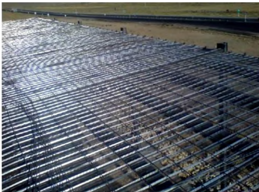
شکل (۱۲-۱۳): تعبیه شبکه آرماتور
