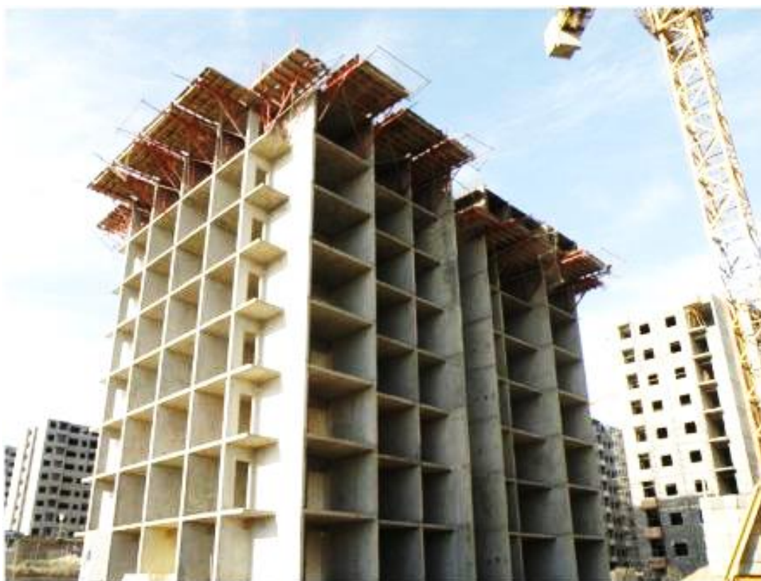
شکل (۷-۲): سیستم پانلی
