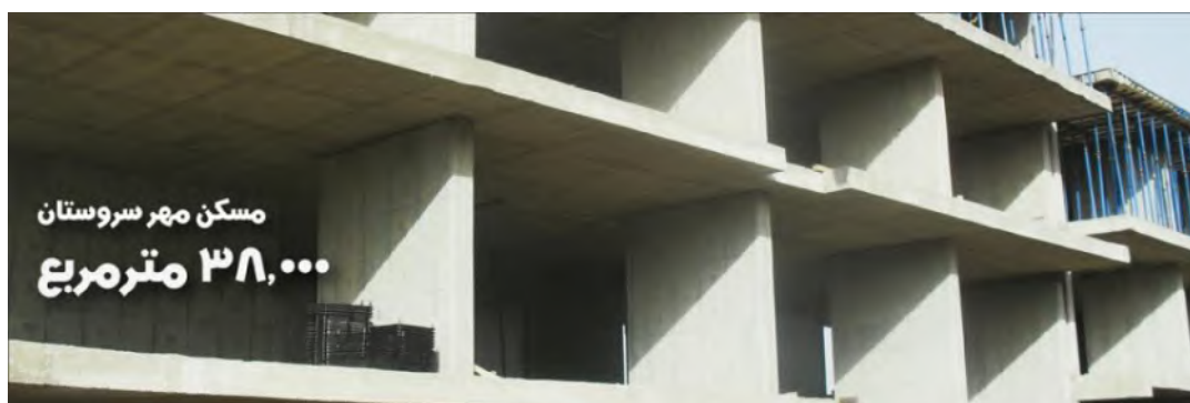
شکل (۷-۲۰): مسکن مهر سروستان در حال احداث
