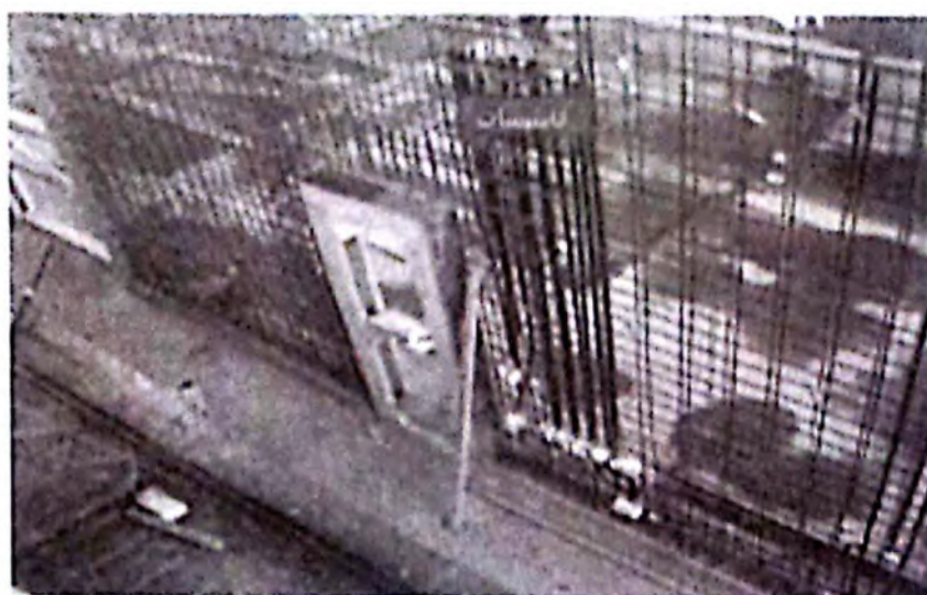
شکل (۳-۱۰): اجرای تأسیسات مکانیکی همزمان در دیوار
