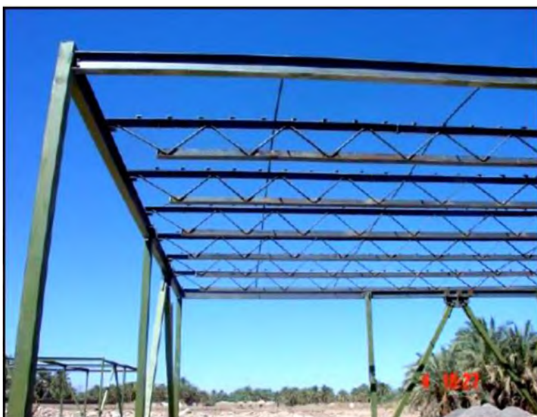
شکل (۱۲-۴): نصب سریع تیرهای دلتا
