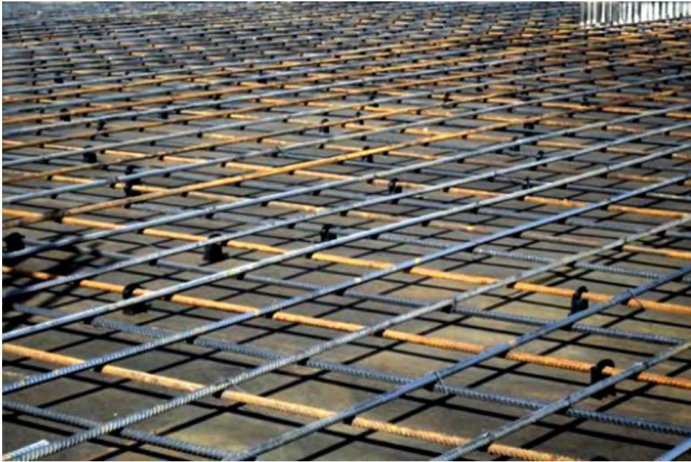
شکل (۶-۷): آرماتورگذاری سفره تحتانی در سقف یوبوت
