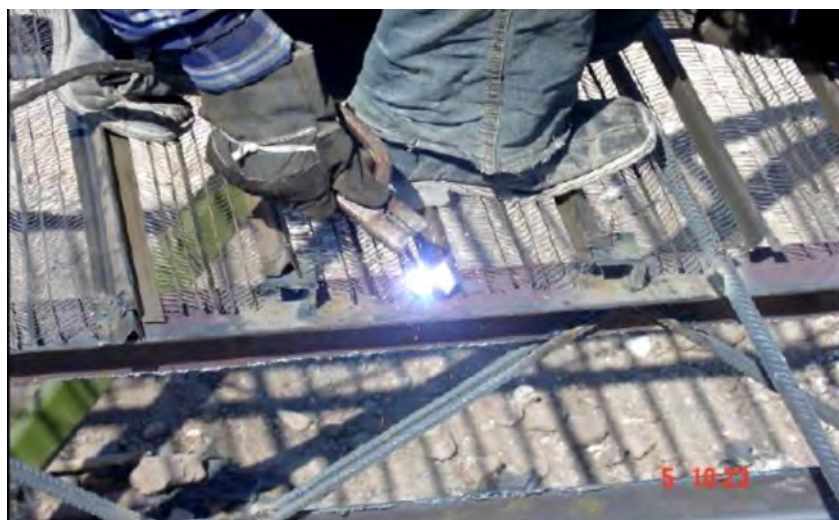
شکل (۱۲-۱۲): خال جوش کردن روفیکس روی تیرها
