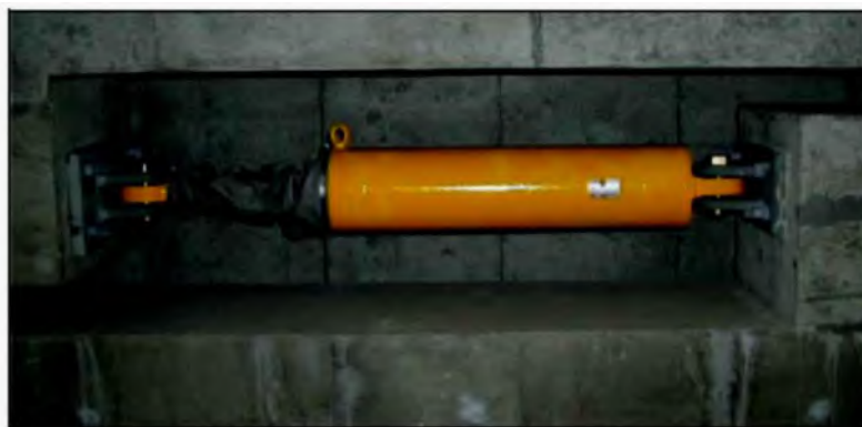
شکل (۹-۱۰): اتصال میراگرهای ویسکوز مایع در کف و فونداسیون سازه‌ها
