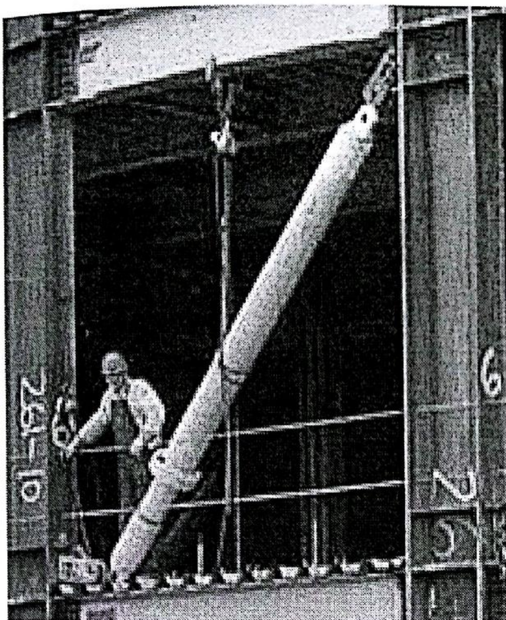
شکل (۹-۱۱): تعبیه میراگر ویسکوز مایع در ساختمان
