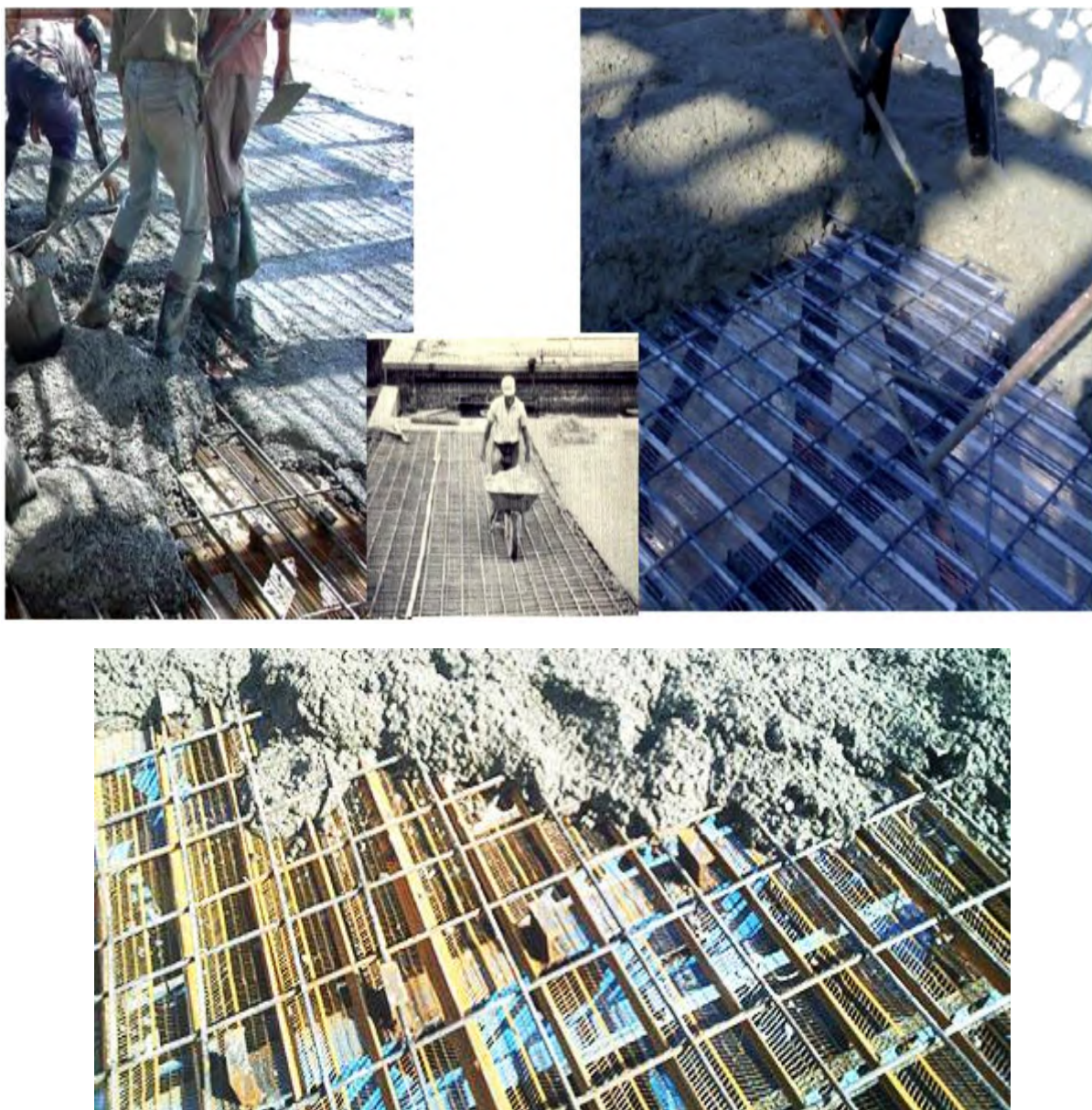
شکل (۱۲-۶): بتن ریزی سقف روفیکس
