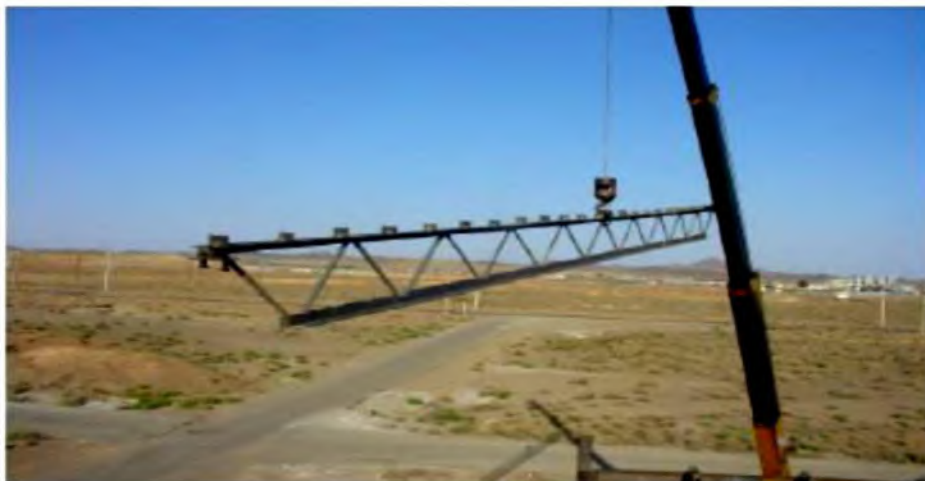
شکل (۱۲-۲): تیر فلزی دلتا
