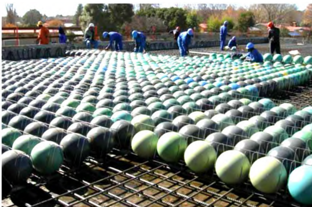
ت- اجرای مش‌بندی فوقانی
