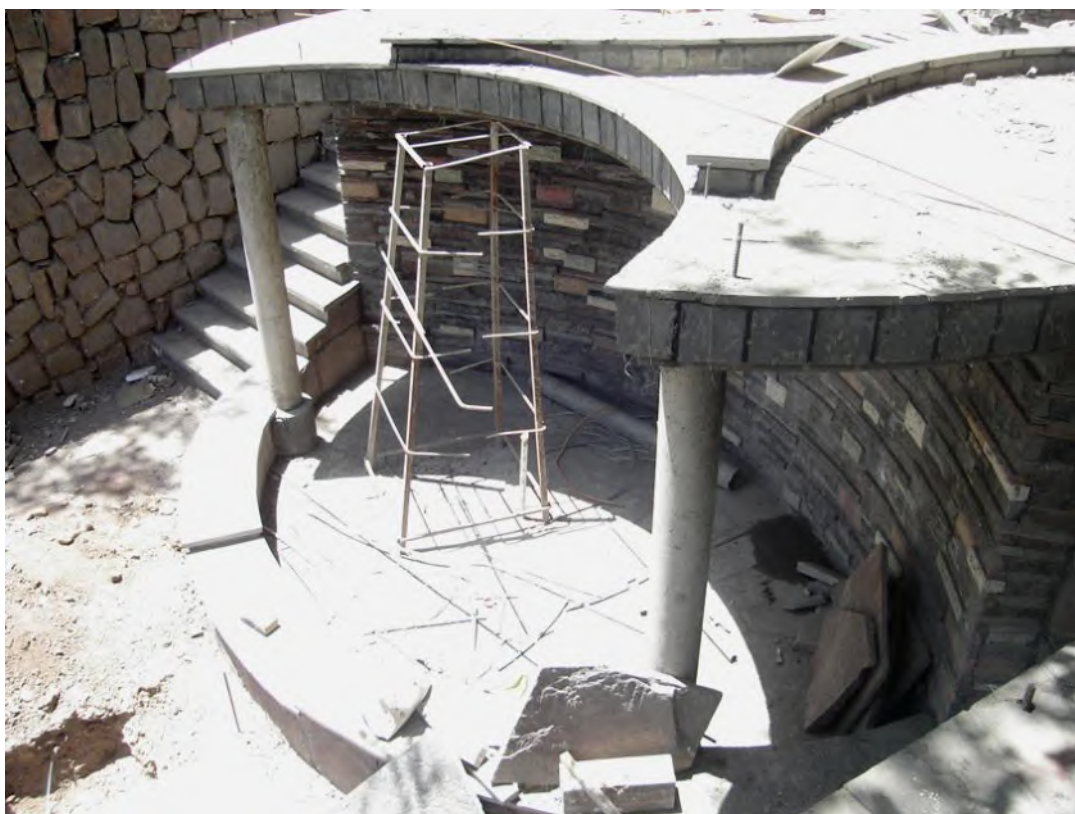
شکل (۷-۱۷): ساختمان یزدی نژاد در حال ساخت
