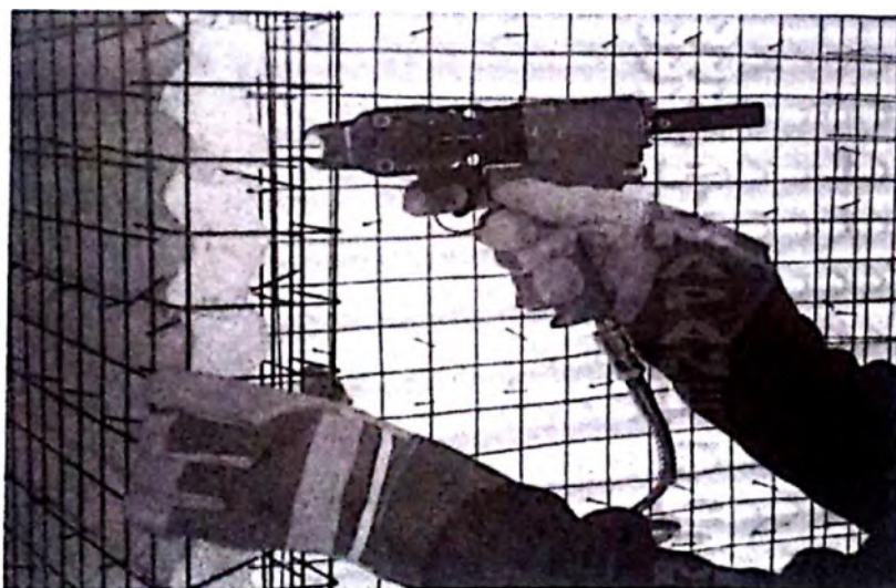
شکل (۶-۸): نصب پانل‌های دیوار و اتصالات
