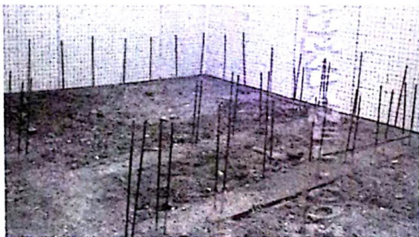
شکل (۶-۷): میلگردهای انتظار در پی
