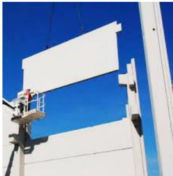
شکل (۵-۵): دیوار برشی بتنی پیش ساخته
