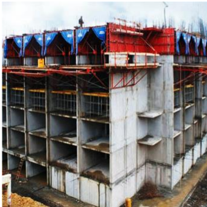
شکل (۳-۱): سیستم قاب بتنی پیوسته (قالب تونلی)
