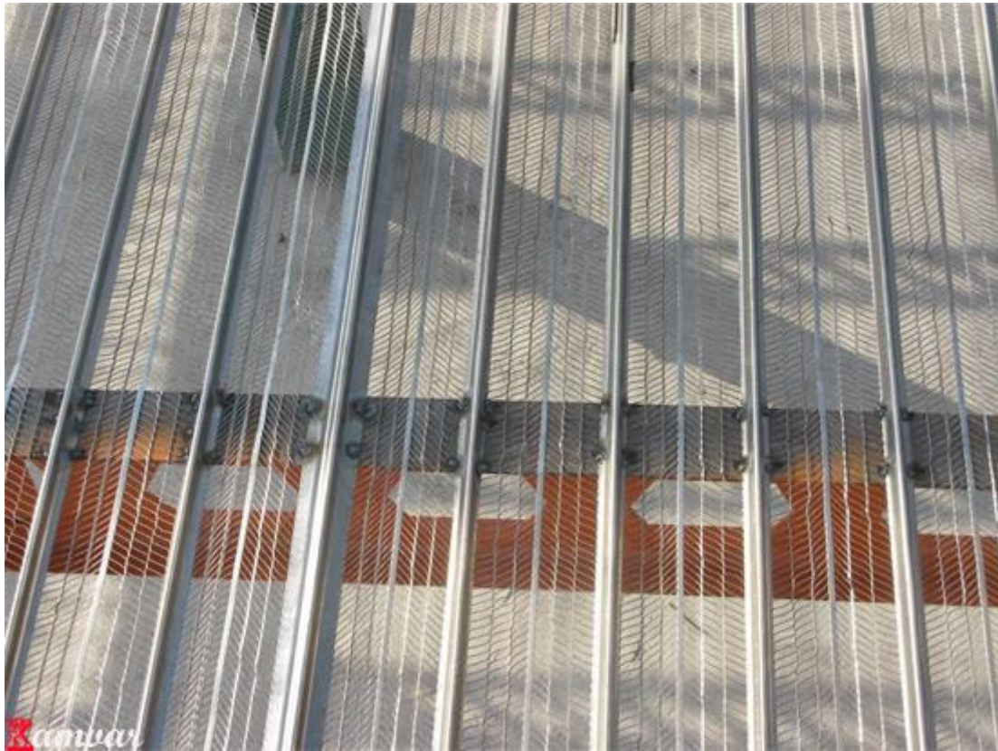
شکل (۱۲-۱): سقف روفیکس
