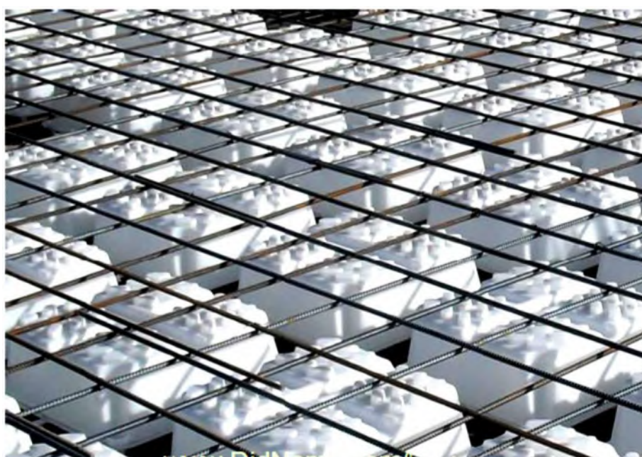
شکل (۷-۸): آرماتورگذاری سفره فوقانی در سقف یوبوت
