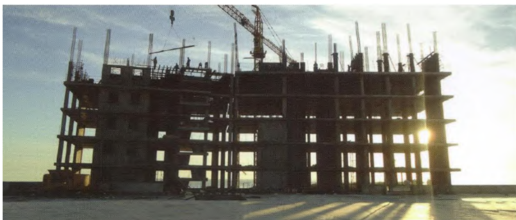
هتل و آپارتمان سپتی سنتر قشم محل پروژه: جزیره قشم بلندترین دهانه: ۷/۵ متر ضخامت دال: ۲۲ سانتی متر زیربنا: ۱۰۰۰۰۰ متر مربع
